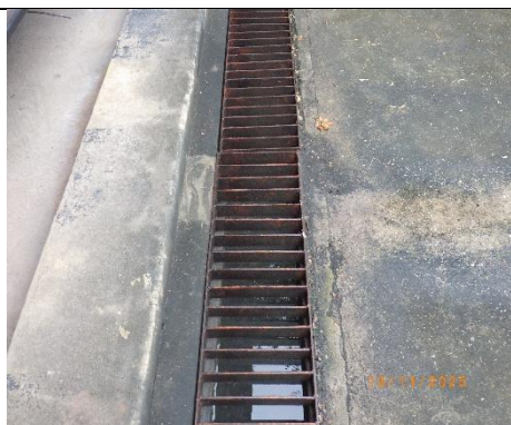
รูปที่ 2-50 ระบบรวบรวมน้ำฝนและรางระบายน้ำฝนภายในพื้นที่โครงการ
