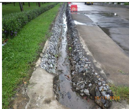
รูปที่ 2-50 ระบบรวบรวมน้ำฝนและรางระบายน้ำฝนภายในพื้นที่โครงการ
